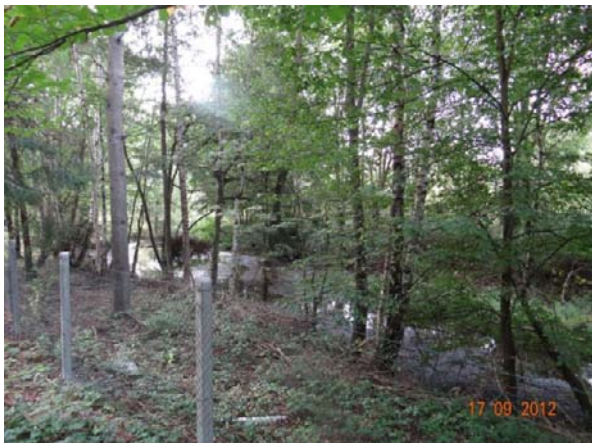
Koryt pod vyústěním krytého profilu v areálu.
